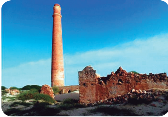
Ilustração 26: Ruínas da fábrica de cerâmica
