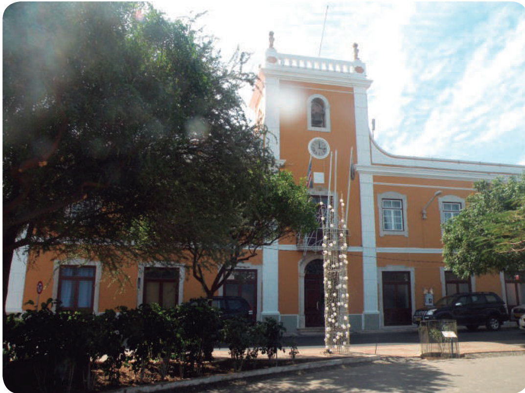
Figura 18: Edifício da Câmara Municipal da Praia Fonte: Equipa Técnica
