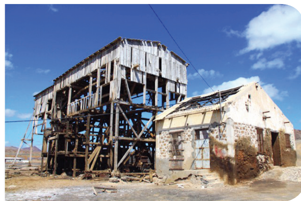
Casa das Máquinas – Pedra de Lume
